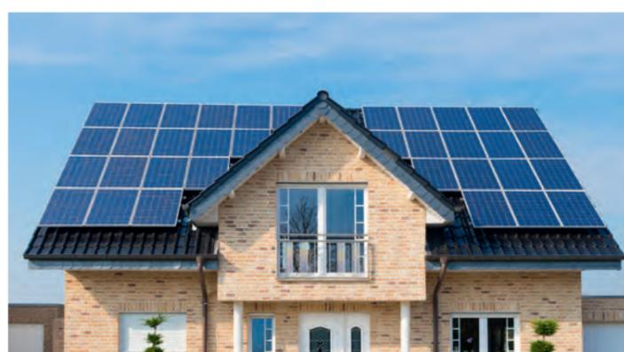
Für die **Aufdachmontage** sind fast alle Dachtypen geeignet. Bei der **Indachmontage** werden die Module bündig in das Dach eingesetzt und Dachziegel ersetzt.
